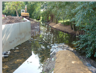
Travaux de finition dans le lit de l'Altbach
