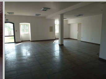
La chapelle en travaux
